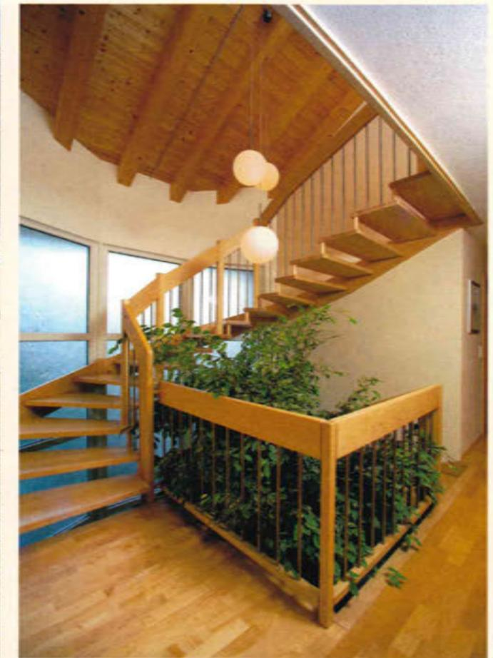
Das offene Treppenhaus erstreckt sich über drei Etagen und besteht in einer freitragenden Konstruktion aus Holz und Metall.
